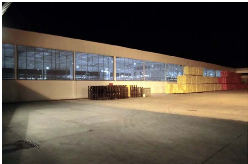
Vordere Fassade der neuen Halle mit großen Lamellenflächen zur Belüftung
