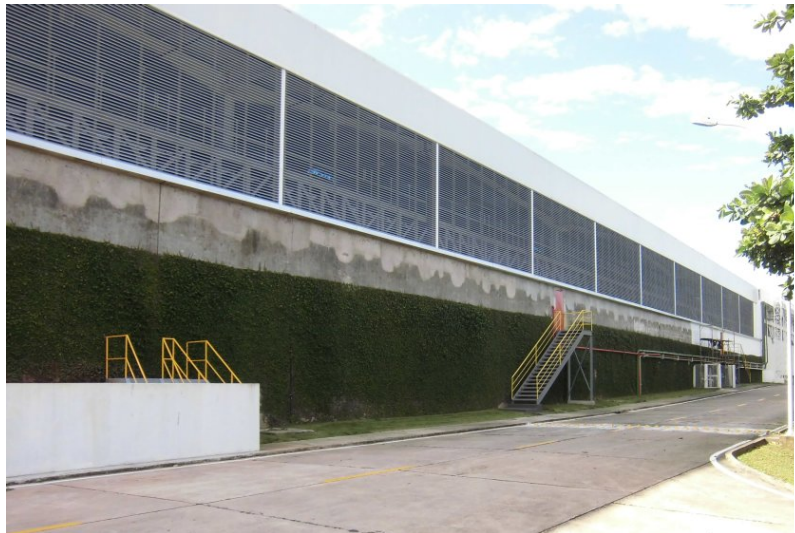
Hintere Fassade der neuen Halle mit großen Lamellenflächen zur Belüftung
