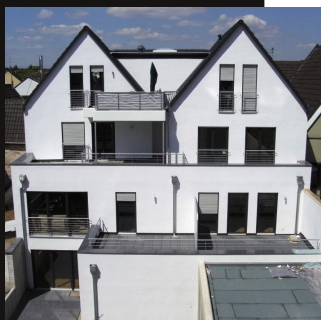
Rückseite Haus Bachstraße
