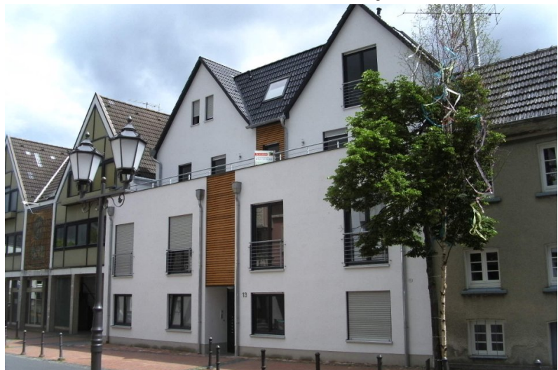
Straßenseitige Fassade Haus Bachstraße
