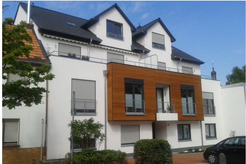
Straßenseitige Fassade Haus Bungert
