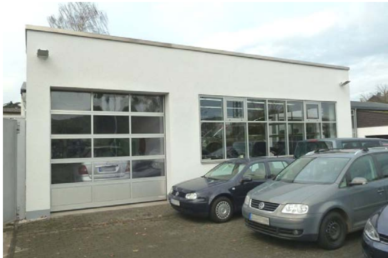
Neues Gebäude für die Dialogannahme
