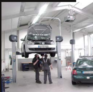
Sanierte, alte Werkstatt
