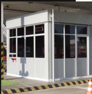
Pfortnerloge an der Zufahrt
