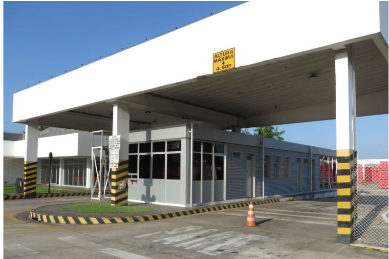
Neue LKW-Pforte, neues Gebäude unter dem vorhandenen Dach
