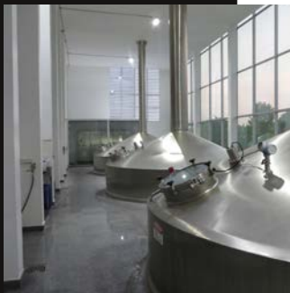
Die neuen Sudkessel
