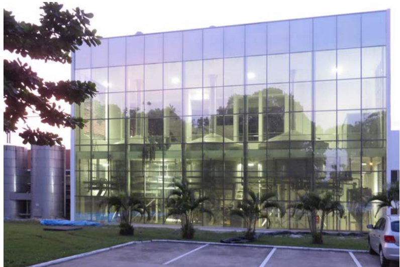
Glasfassade an der Straßenseite des Gebäudes
