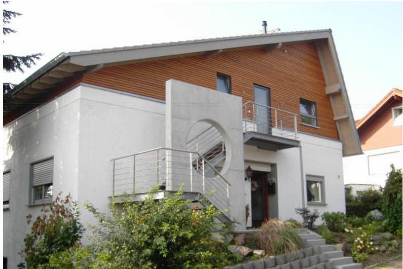
Straßenseite des Hauses
