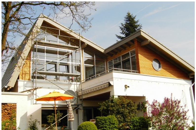
Gartenseite des Hauses (noch mit Gerüst)
