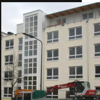
Fassade Werstener Feld in der Bauzeit
