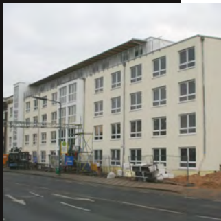
Fassade Werstener Feld in der Bauzeit
