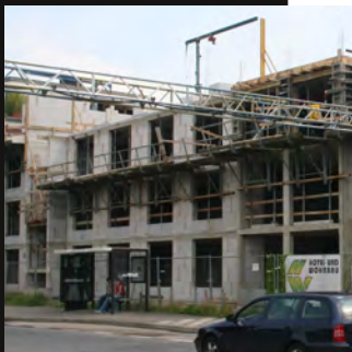
Fassade Werstener Feld in der Bauzeit
